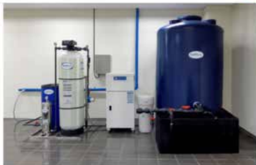
Hình 5. Hệ thống sản xuất nước rửa NaoClean từ muối ăn
